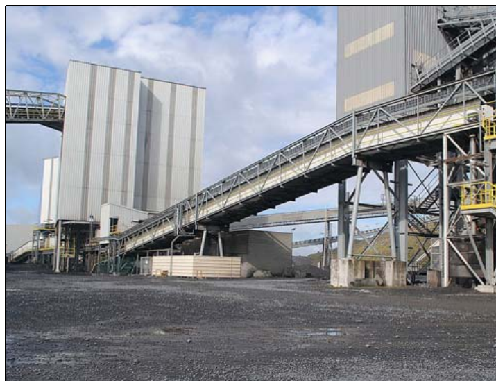
Links op de achtergrond de breekinstallatie, met op de voorgrond de TB1
